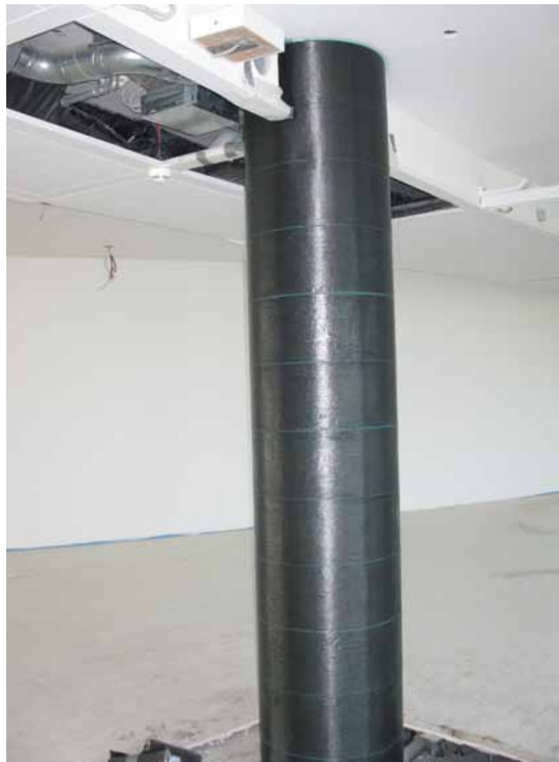
Anwendungsfall Klebarmierung Sky-Office, Frankfurt: Bei den Stützen war die planmäßige Betongüte nicht erreicht worden. Die 60 bis 80 cm dicken und 3,30 Meter hohen Stützen mussten zentrischen und leicht exzentrischen Belastungen standhalten. Auf der gesamten Länge wurden radial verklebte CFK-Sheets in fünf bis sechs Lagen aufgebracht. Der Verstärkungsgrad betrug ca. 30 %. Neben dieser etablierten Technologie wird in Zukunft auch Tudalit® zur Verstärkung eingesetzt.
