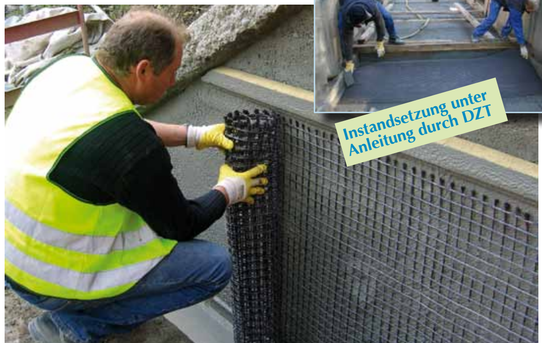
Großes Bild: Textile Oberflächenbewehrung am Bahnhofsdurchlass.
